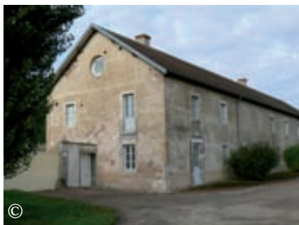
LE BÂTIMENT QUI ACCUEILLE LES LOCAUX DU CERCCIS, EN COURS DE RESTAURATION
